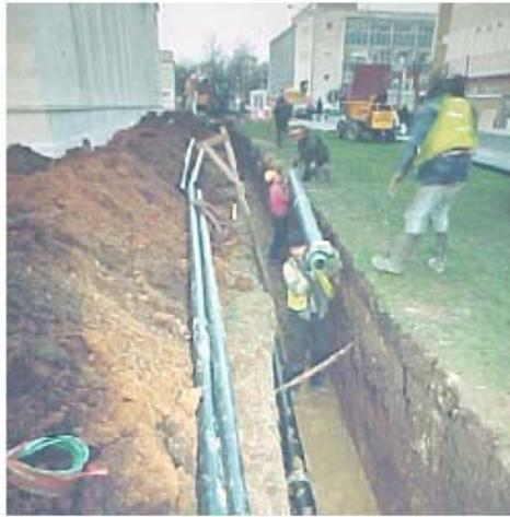
Figura 18 - Colocação da canalização do sistema de *district heating* (Fonte: Energie-Cités)
