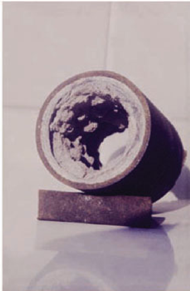
Crostras de carbonato de cálcio em tubo de sistema de geração de vapor.
